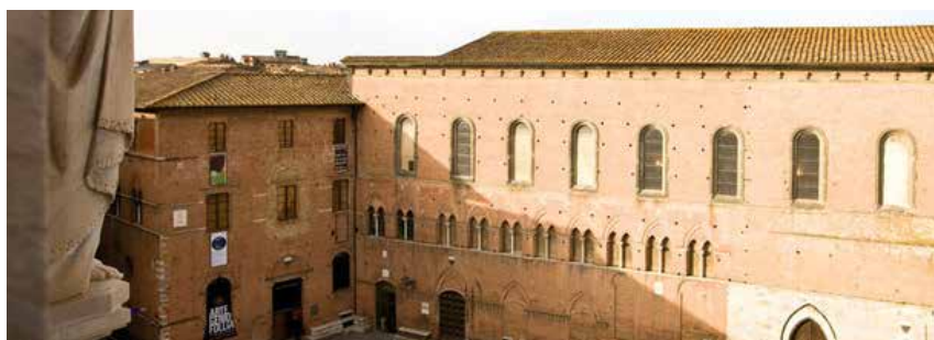
Restauro di Immobili Sottoposti a Tutela
