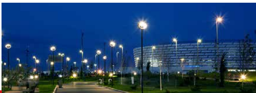
Impianti di Pubblica Illuminazione
